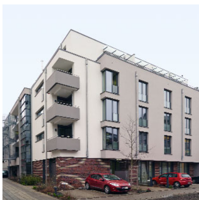
Le résidentiel collectif est idéal pour l'installation des modules thermiques d'appartement Weishaupt
