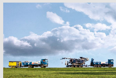
Forages géothermiques avec la filiale BauGrund Süd de Bad Wurzach
