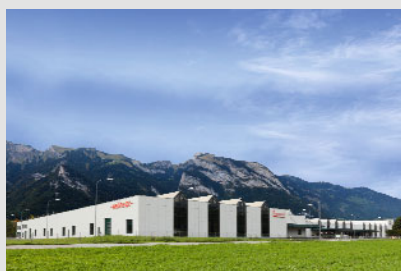
Production de chaudières à l'usine Pyropac AG de Sennwald (CH), filiale du groupe Weishaupt
