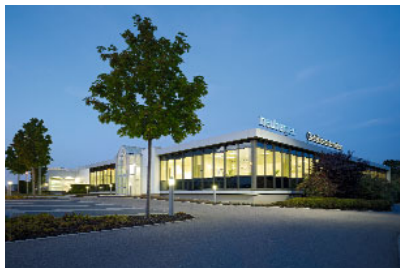
Bygningsautomatik fra Neuberger Gebäudeautomation i Rothenburg ob der Tauber, Tyskland
