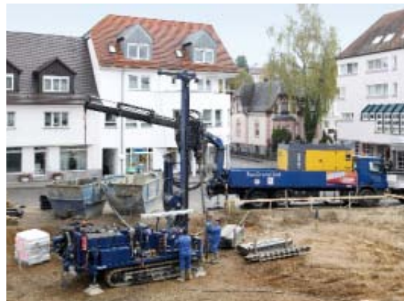
Weishaupt de A à Z : la filiale Baugrund Süd réalise les forages pour la mise en place des pompes à chaleur.
