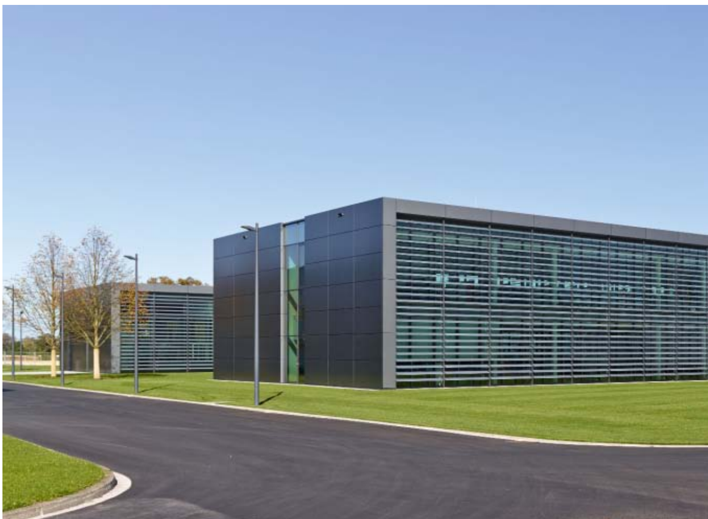
Disposition rectiligne de part et d'autre de l'entrée : ce bâtiment du site de Schwendi abrite le Centre de recherche et de développement.
