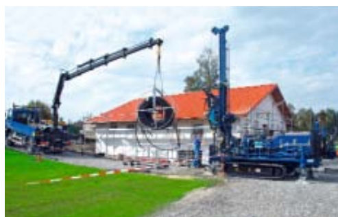
La filiale Baugrund Süd est spécialisée dans la géothermie et le forage.
