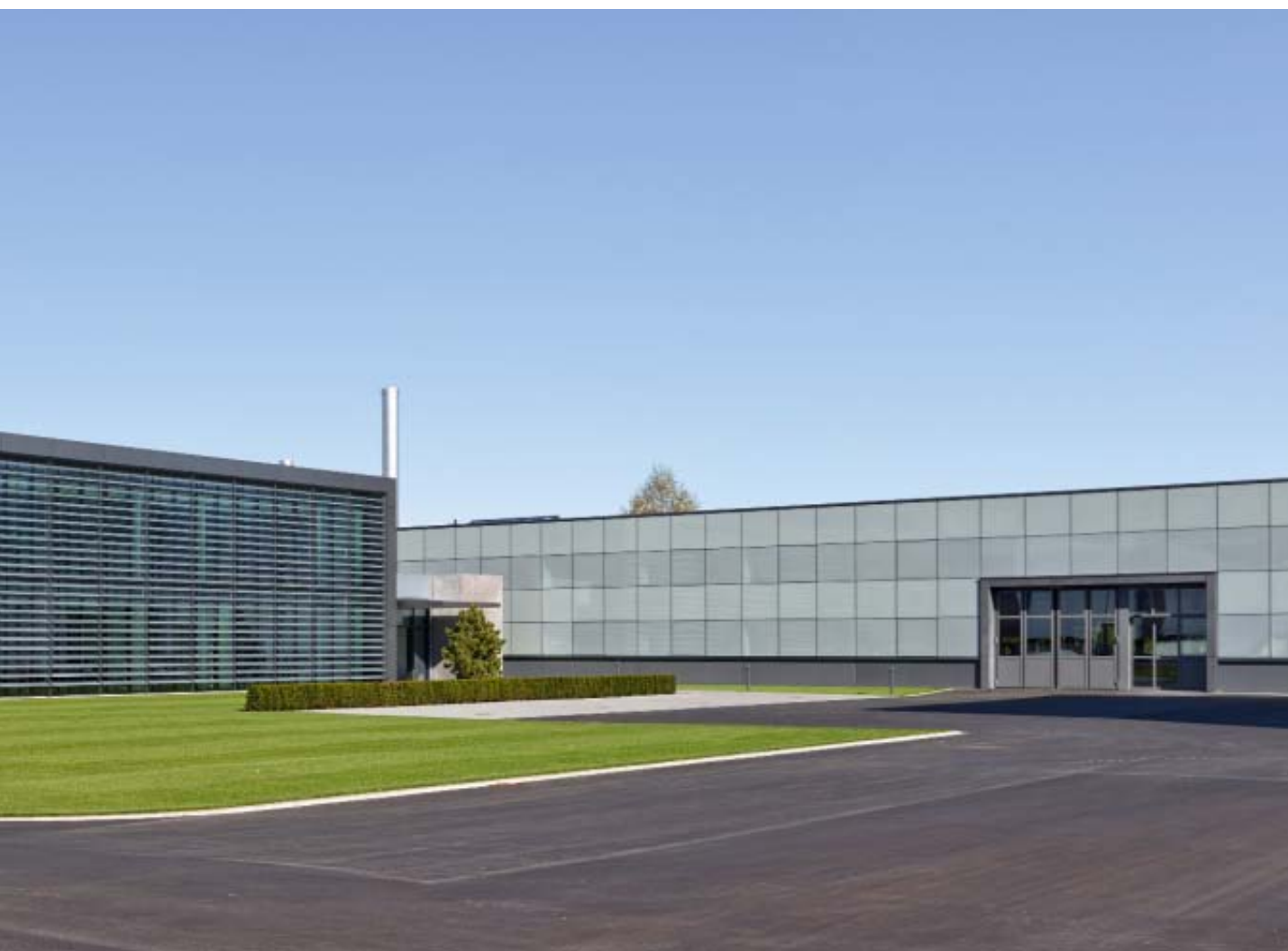
La partie gauche du bâtiment, ajoutée par la suite, vient encrer le gigantesque tube d'essai.
