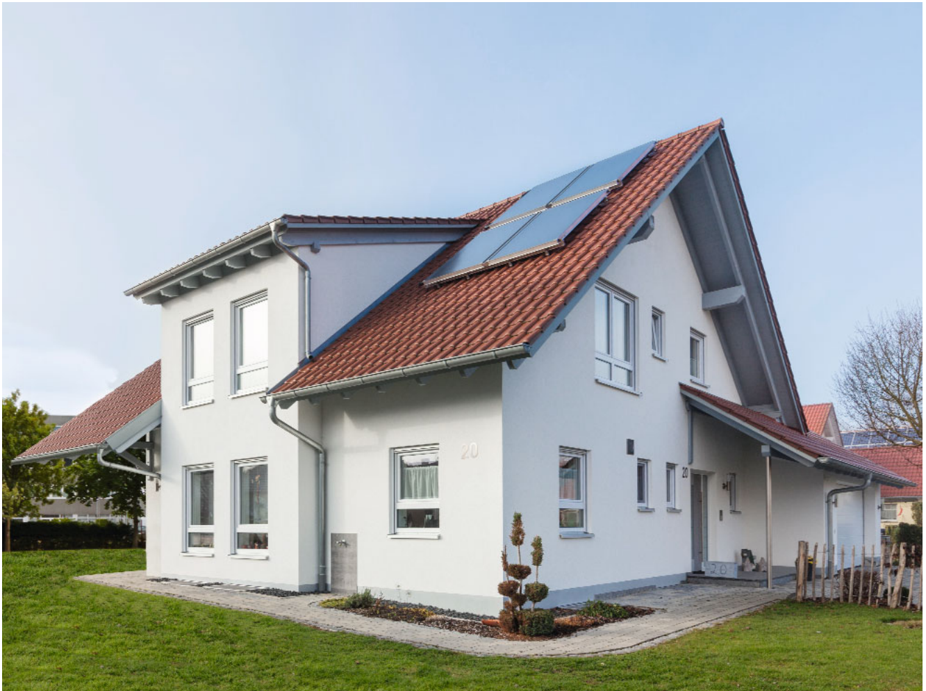
Installation solaire destinée à la préparation d'eau chaude sanitaire et à l'appoint chauffage
