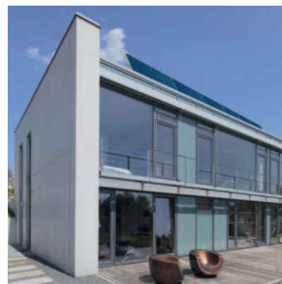
Montage sur toit plat
